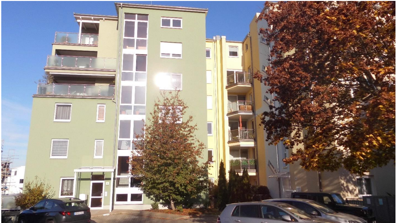
Hausansicht mit Eingang (Südseite)
